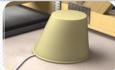
Réalisez une petite fente à la base de la cloche de protection pour spot pour le câble
